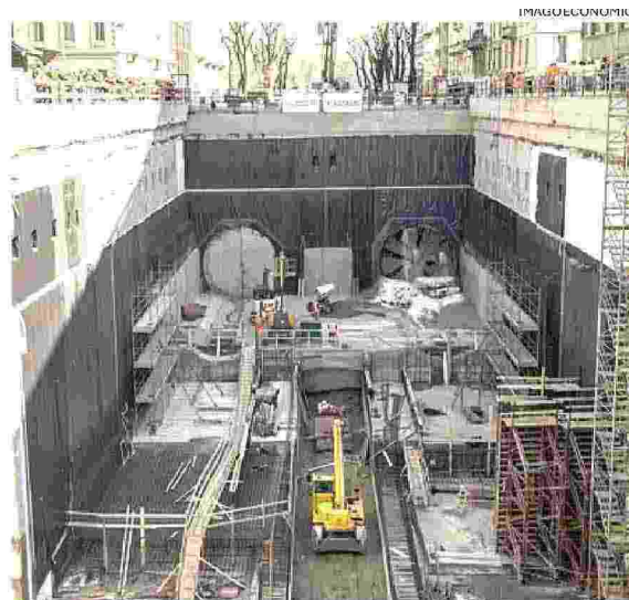
Milano. Lo scavo per la costruzione della linea 4 della metro
